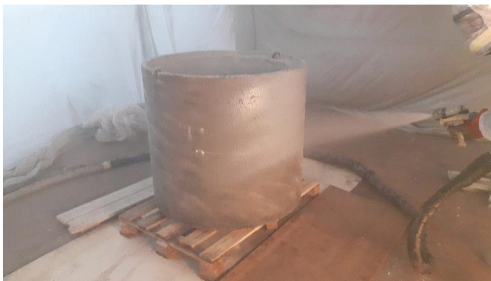
Rys. 4. Natrysk powłoki z polimocznika (źródło: fotografia własna)
