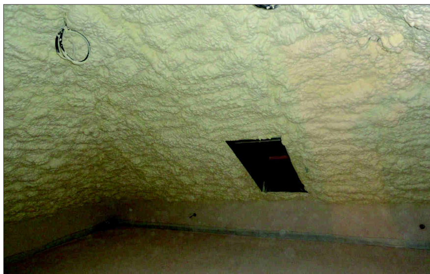
Fot. 2. Poddasze ocieplone pianą otwartokomórkową
