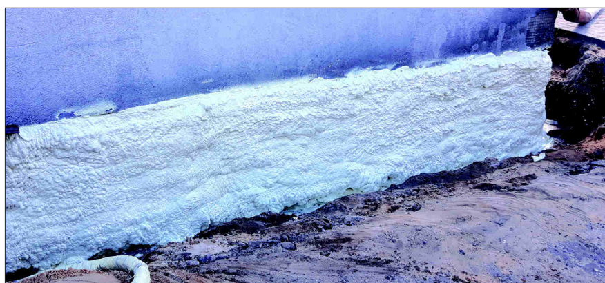
Fot. 3. Fundamenty ocieplone pianą zamkniętokomórkową
