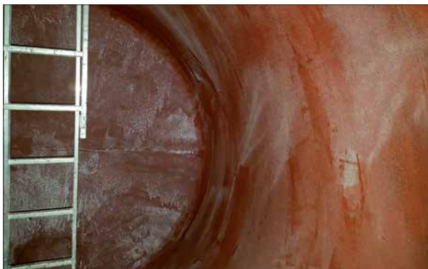
Fot. 11. Powierzchnia stalowa zbiornika przygotowana pod aplikację polimocznika (archiwum firmy Compact-Project)
