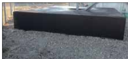
Fot. 4. Użycie materiałów bitumicznych do izolacji fundamentów (archiwum firmy Compact-Project)
