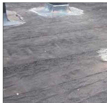
Fot. 3. Użycie papy do izolacji przeciwwodnej dachu (źródło własne)
