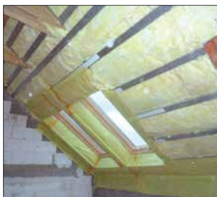
Fot. 2. Użycie wełny mineralnej do izolacji termicznej poddasza (archiwum firmy Compact-Project)
